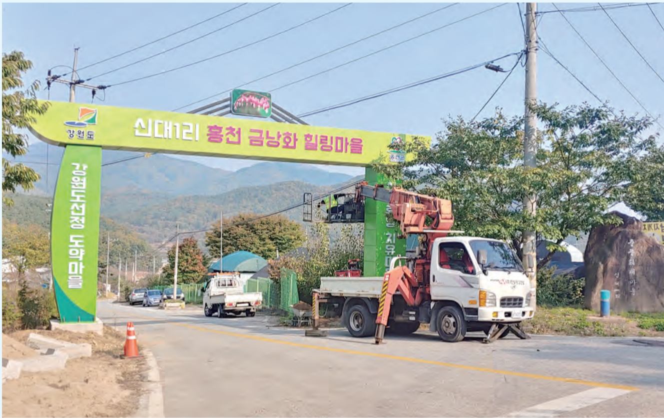
◇마을입구 대형간판 및 마을안내판 설치 모습
